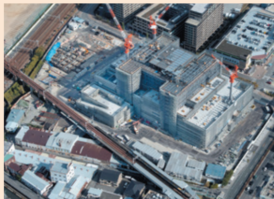
建設中の統合新病院の空撮写真（2025年1月）
